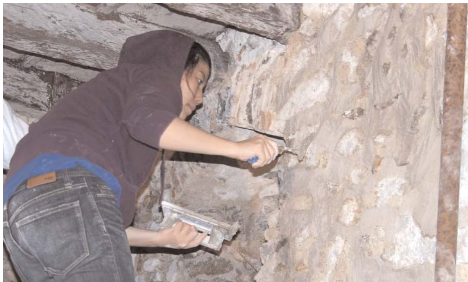
Réfection de la pièce qui accueillera les toilettes de la villa des Gondi. Ici, une jeune Coréenne applique un enduit sur le mur, étape nécessaire avant d'attaquer les finitions.
